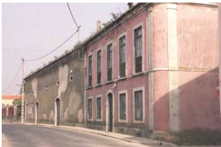
Fachada da Casa e Adega Camilo Alves, Bucelas, 2004
